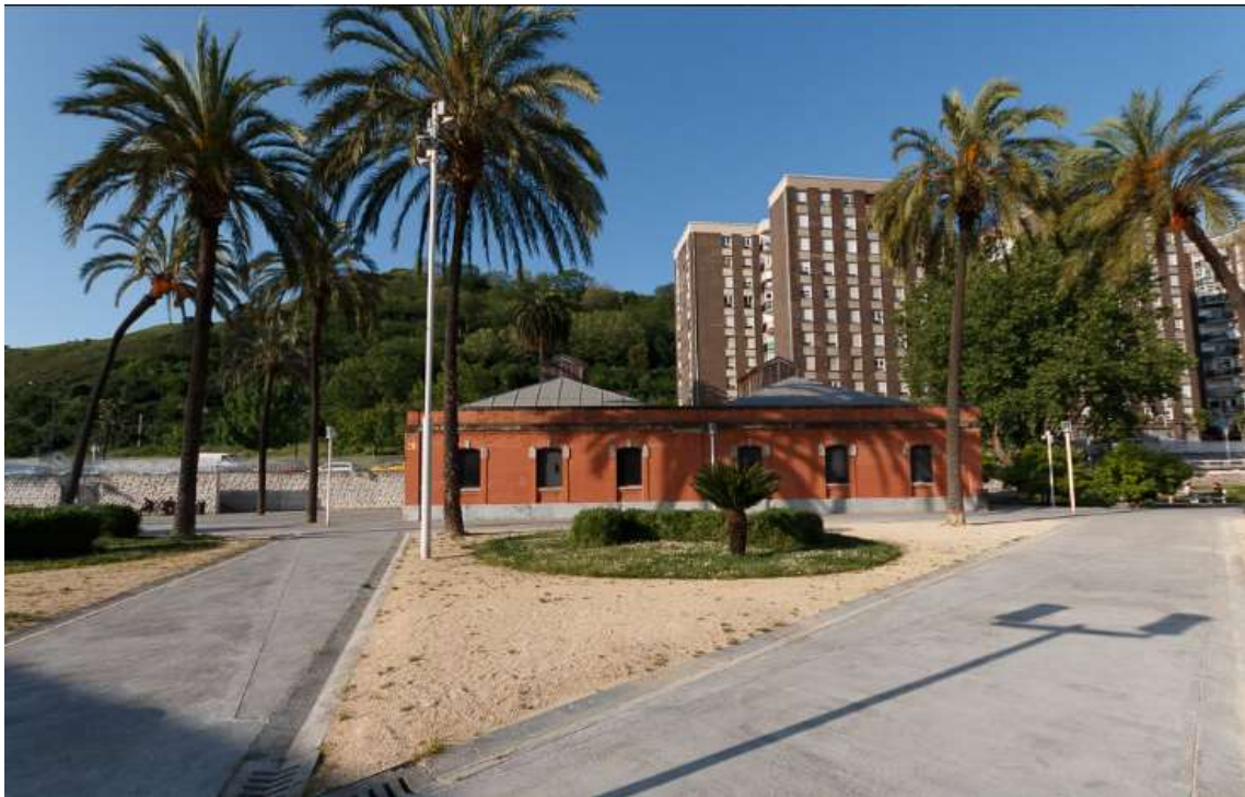
Elorrietako ponpa-etxe. Iturria: https://ondarelagunak.eus/bombeadora-de-elorrieta/
